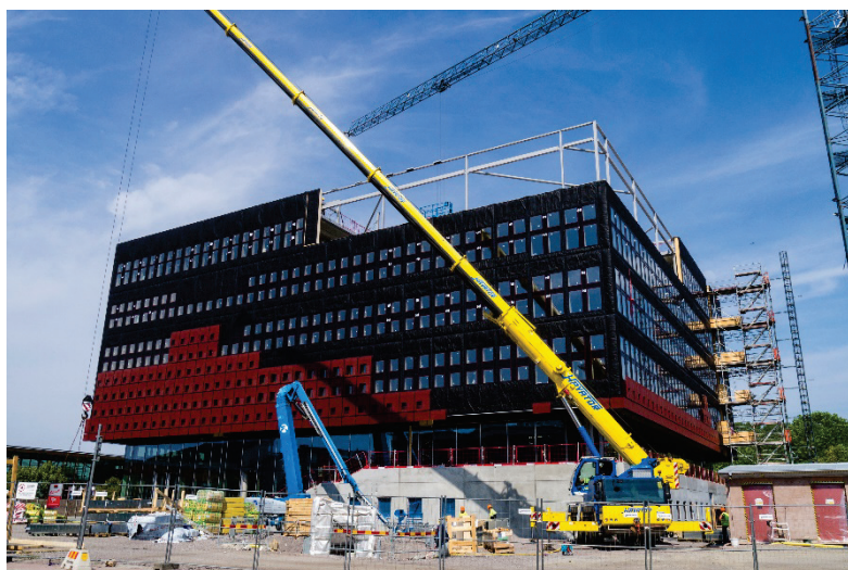
Bild 75 Studenthus Valla under uppförande. Augusti 2018. Foto: Peter Karlsson.
