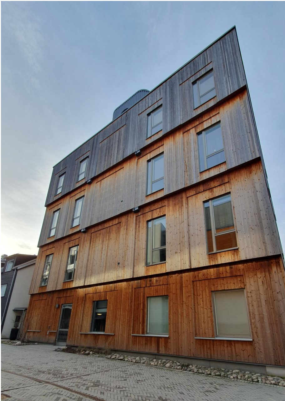
Figur 3. Bostadshuset Delfinen år 2024 med livförskjutningar och stående träpanel som skiftar i färg.
