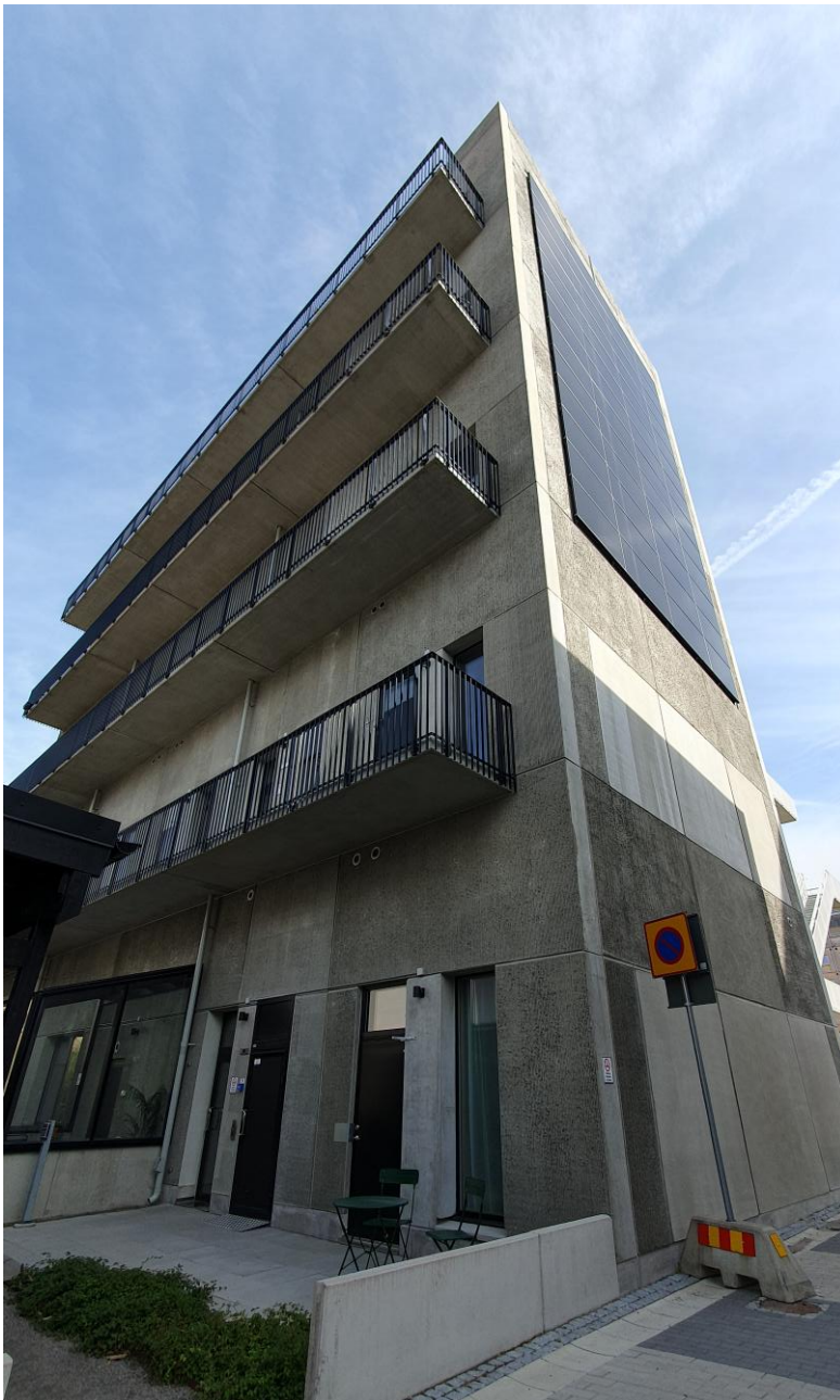
Figure 6. Bostadshuset Bocce med fasadsolceller mot söder.
