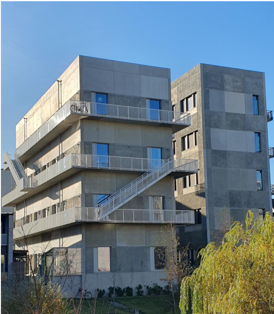
Figur 5. Bostadshusen Bocce och Mostra med gavlar mot Broparken.
