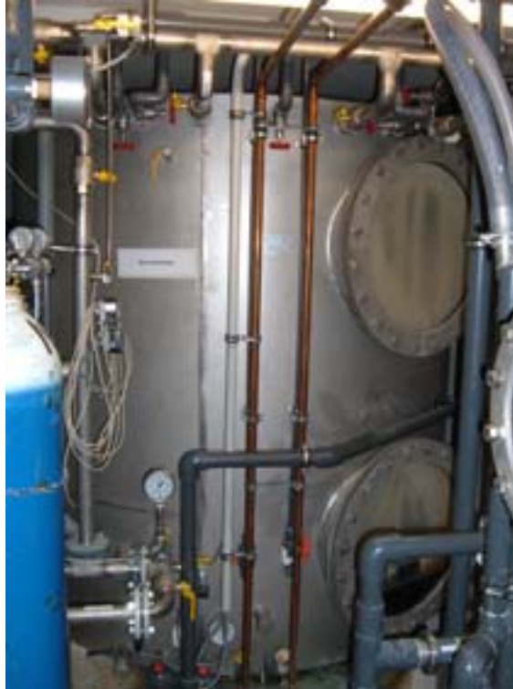
Figur 36. Biofilter som är indelad i tre nivåer (foto: Johan Benjaminsson).
